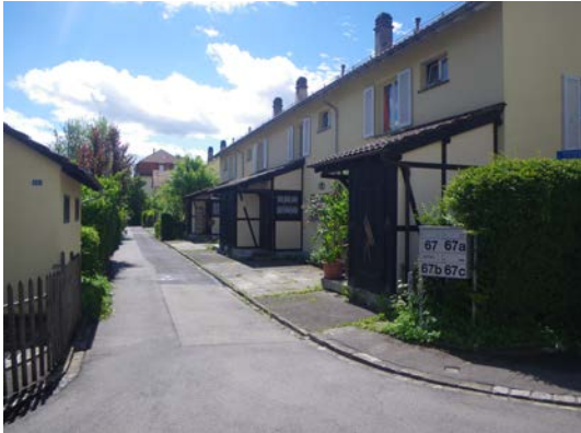
Abschliessbare Unterstände bei Hauseingang
