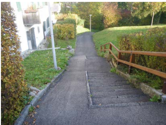
Niveau-Unterschied bei Hauszufahrt (MFH)
