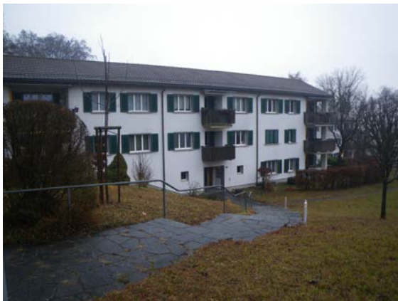
Fussweg zu MFH mit Beleuchtung/Handlauf
