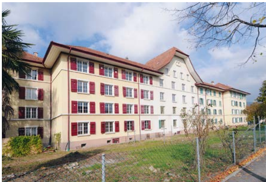
Die Siedlung mit den fünf zusammengebauten Häusern steht unter Denkmalschutz.
